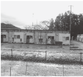
校庭の仮設住宅解体前
